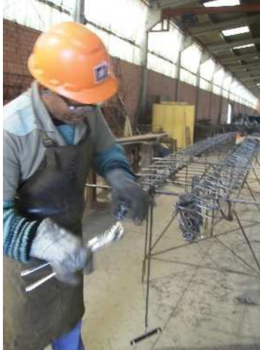
Figura 5 – Operação da amarração dos estribos.
