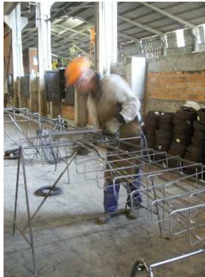
Figura 3 – Posicionamento de estribos.
