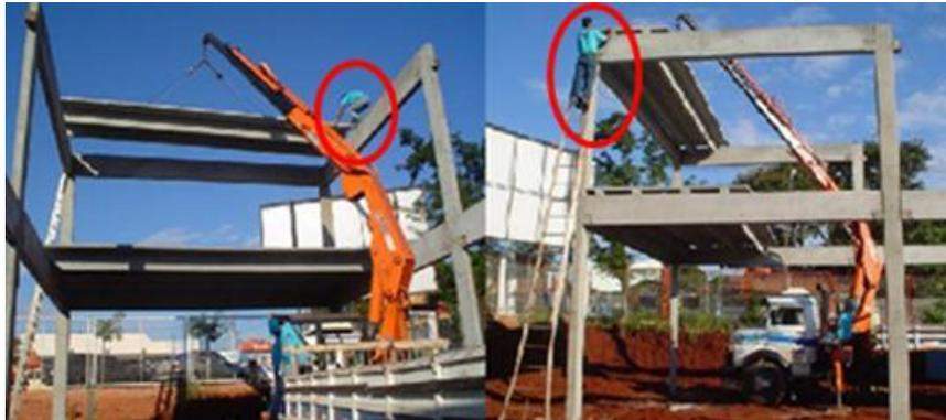
Figura 6 – Trabalhadores realizando a montagem dos pré-moldados
