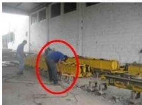
Figura 5 – Posição das formas de pré-moldados
