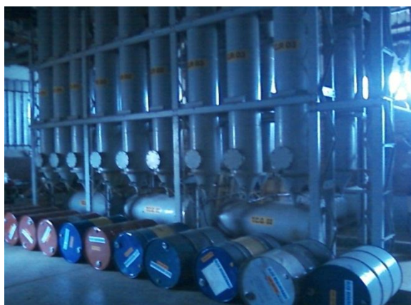
Imagem 5 - Torres de filtragem
