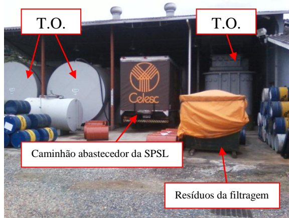
Imagem 4 – Detalhes armazenamento e transporte de óleo
