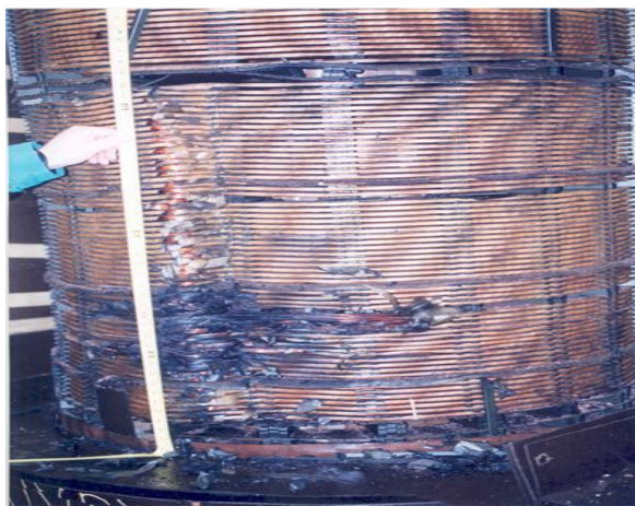
Imagem 8 – Curto circuito em bobinas gerado por arco
