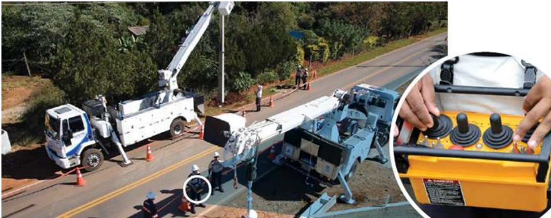
FIGURA 1: Aplicação Digger Derrick . FONTE: Site da Elektro (Acesso em 23 de Junho de 2012)
