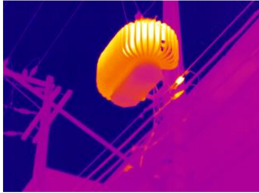
Figura 8: Aquecimento do barramento de neutro.
