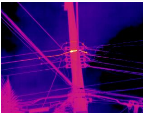
Figura 5: Aquecimento no jumper de baixa tensão.
