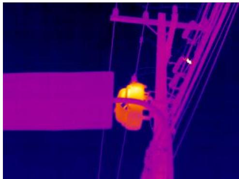
Figura 9: Aquecimento no fechamento na chave da fase B.
