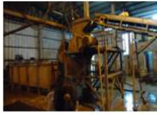
Figura 8: Tanque de lavagem com facas
