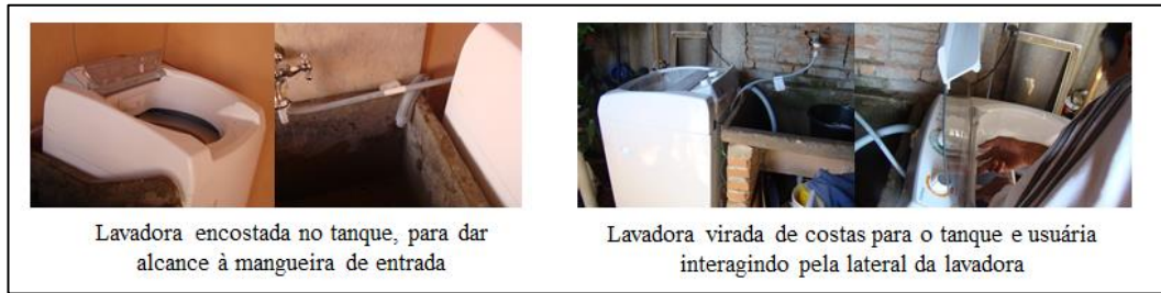
Figura 5 – instalação das lavadoras com mangueira de entrada de água que não alcançaram a torneira.
