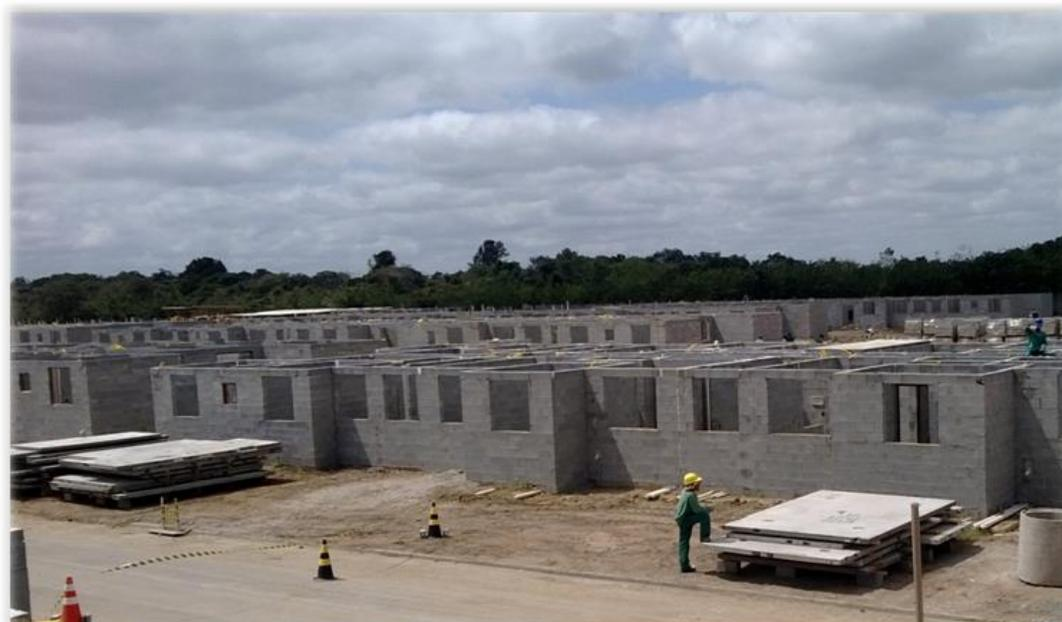
Figura 7 - Local do estoque das lajes para içamento
