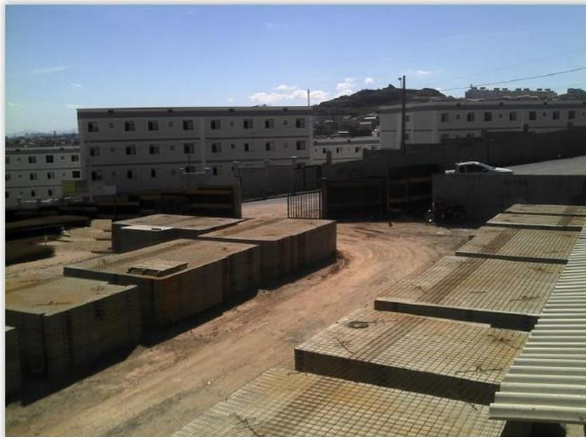
Figura 3 - Pista laje içada
