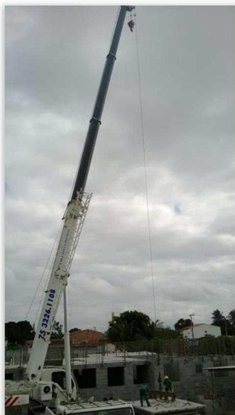
Figura 9 – Içamento da laje
