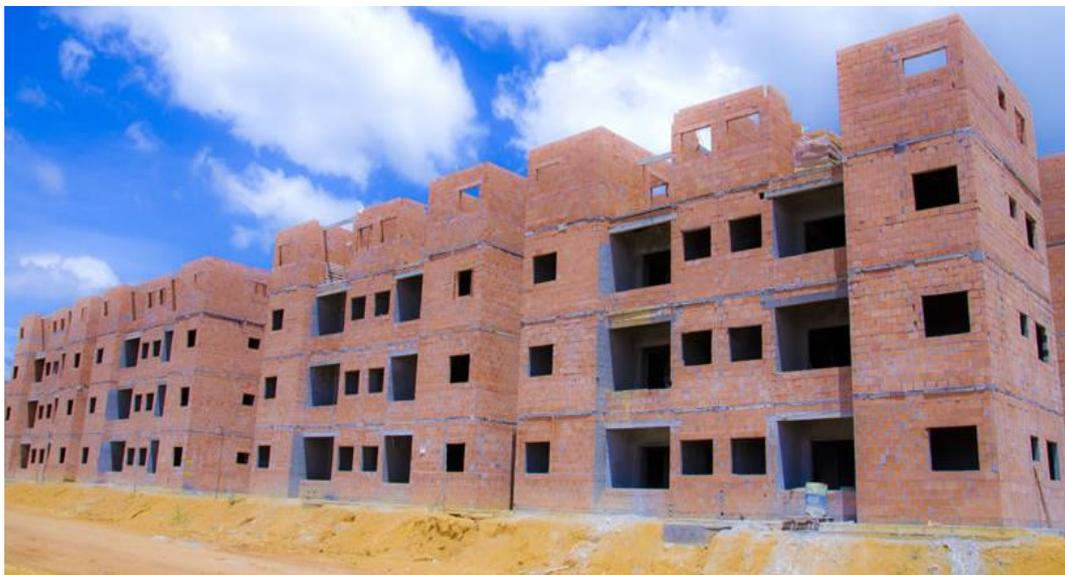
Figura 1- Estrutura em Alvenaria Estrutural
