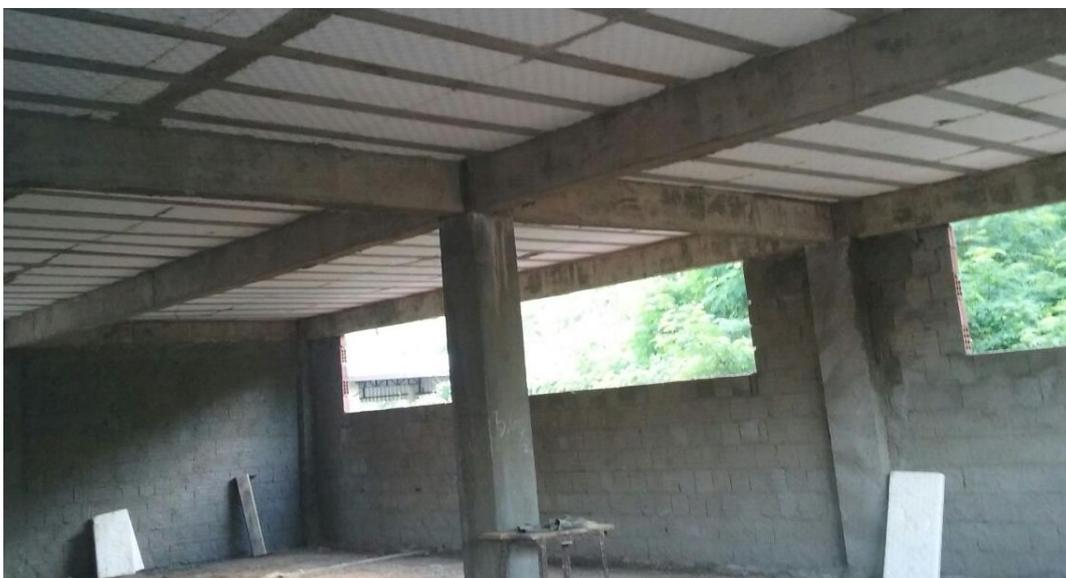
Figura 2 – Vista interna da alvenaria convencional em concreto armado
