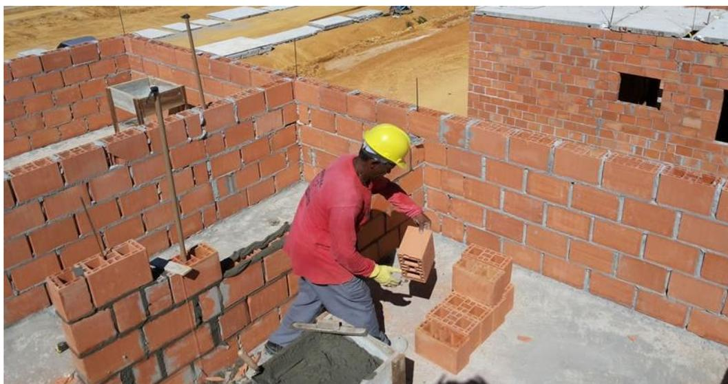
Figura 4: Elevação da Parede
