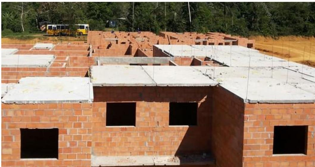
Figura 5: Construção da Laje Superior
